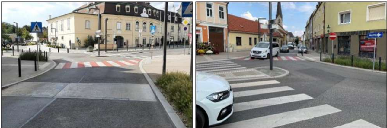
Abbildung 39: Links: Fußgängerüberwege am Knotenpunkt Leopold-Gattringer-Straße/Kirchengasse und rechts: überbreite Kirchengasse im Bereich des Fußgängerüberwegs (Quelle: BERNARD Gruppe ZT GmbH)
