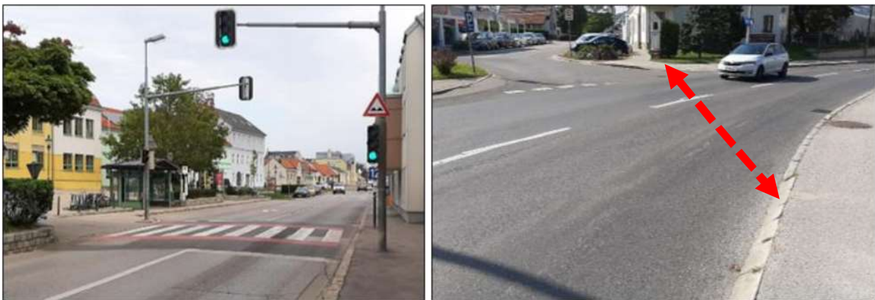
Abbildung 38: links: lichtsignalisierte Fußgängerschutzanlage nördlich der katholischen Kirche und rechts: fehlende Fußgängerquerung an der Wiener Straße (Quelle: BERNARD Gruppe ZT GmbH)
