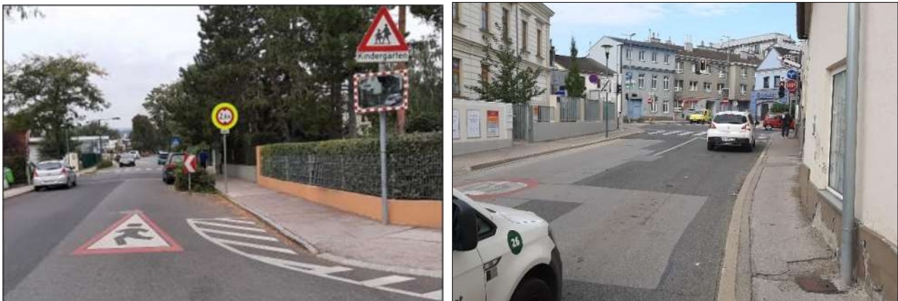
Abbildung 37: Links: Markierung und Beschilderung im Bereich einer KiTa und rechts: nicht ausreichend dimensionierter Gehweg an der Bahnstr. östl. Wienerstr. (Quelle: BERNARD Gruppe ZT GmbH)
